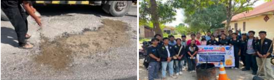
Gambar 3. Hasil Akhir Struktur Perbaikan Darurat Metode Lapen yang Solid dan Rata dengan Permukaan Jalan Eksisting di Jalan Taebenu
