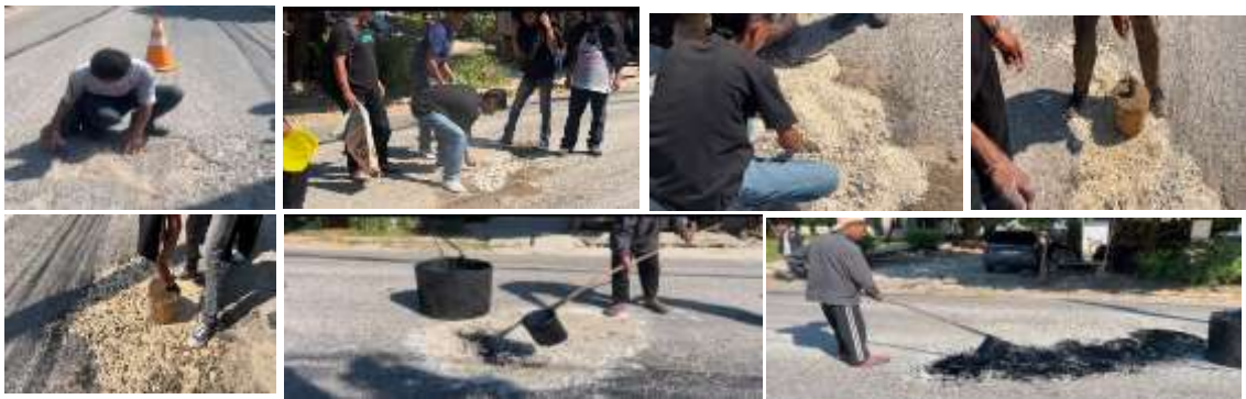
Gambar 2. Dokumentasi Praktik Lapangan: Pemuda Karang Taruna Melakukan Penghamparan Agregat Pokok dan Penyiraman Aspal Cair Panas di Titik Lubang Jalan Taebenu
